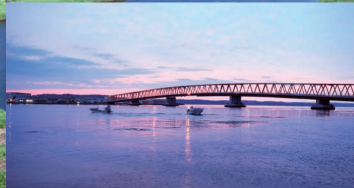
厚岸大橋：1969年(昭和44)から3年の月日をかけて架けられた、長さ456.5m、北海道で最初の海上橋です。
